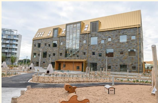
Brage förskola, Stadsfastigheter
